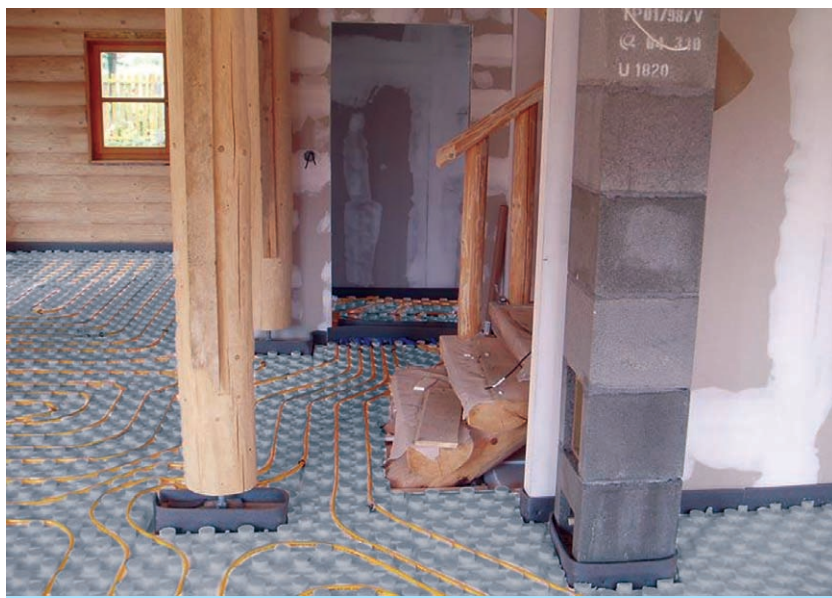
Podlahové topení v roubené chalupě
